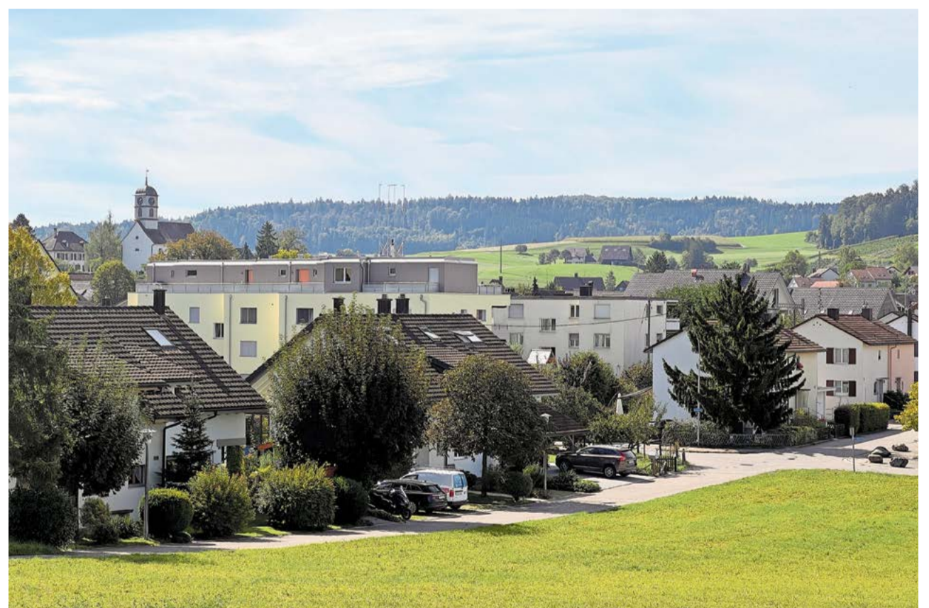
Das Baugespann auf dem Mehrfamilienhaus zeigt an (Bildmitte), wo die Mobilfunkantenne gebaut werden könnte.
